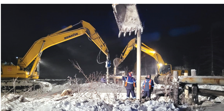
➤ Бурение скважин под опоры трубопровода и погружение свай на реконструкции метаноопровода Тухард-Мессояха.
